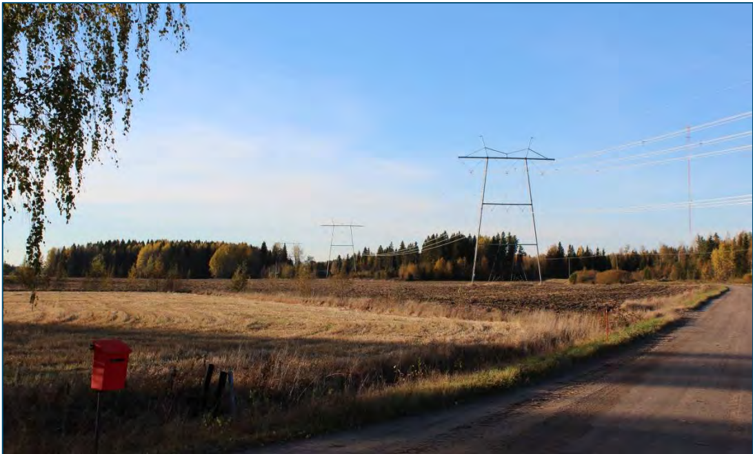
Kuva 5.5. Valokuva nykyisestä 400 kV+110 kV voimalinjasta hankealueen koillispuolella // (Kuva FCG// Hans Vadbäck)
