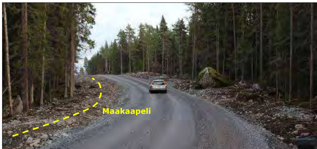
Kuva 5.3. Esimerkki tuulivoimapuiston rakennus- ja huoltotiestä. Maakaapelin oja on sijoitettu tien vasemmalle puolelle (Kuva: Hans Vadbäck / FCG).
