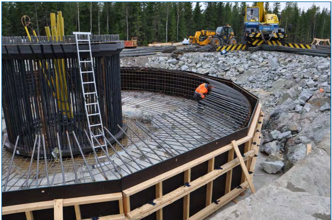
Kuva 5.8. Tuulivoimalan perustusten rakentamista. (Kuva: Leila Väyrynen, FCG)
