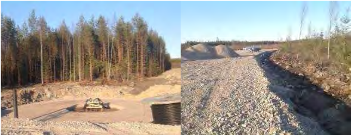
Kuva 10.39 Esimerkki tuulivoimaloiden rakentamisesta. Vasemmassa kuvassa perustuksen betonivalu ja oikealla voimaloiden kuljetustie. Valokuvat on otettu Närpiön Svaskullan viiden voimalan tuulivoimapuiston työmaalta.
