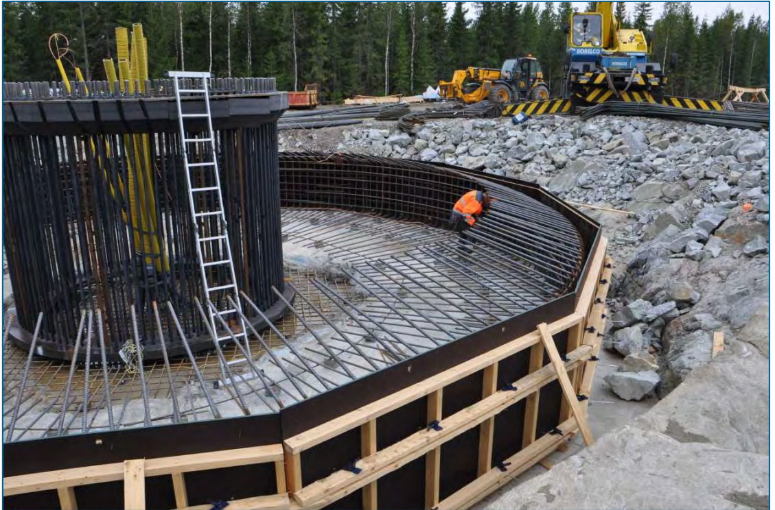
Kuva 5.20. Tuulivoimalan perustusten rakentamista. (Kuva: Leila Väyrynen, FCG)
