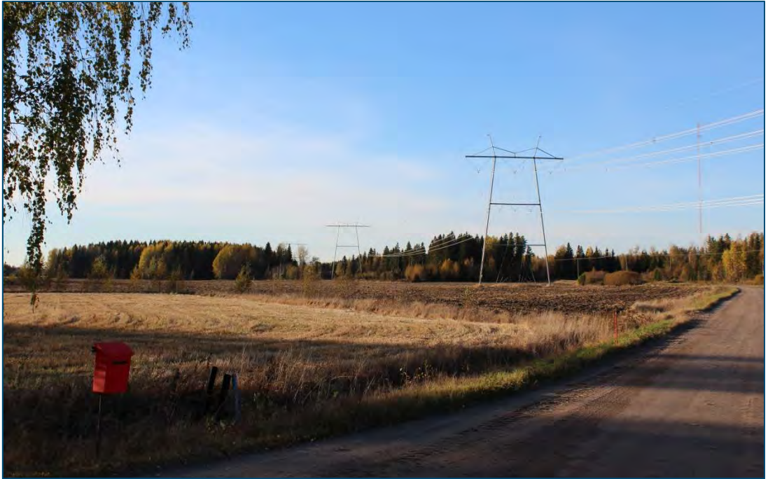
Kuva 5.14. Valokuva nykyisestä 400 kV+110 kV voimalinjasta hankealueen koillispuolella // (Kuva FCG// Hans Vadbäck)
