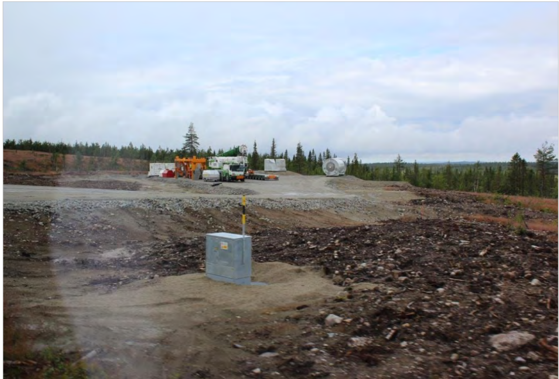
Bild 5.4. Monteringsområde för ett vindkraftverk. På fotot syns bland annat kraftverkets maskinhus och en mindre hjälplyftkran (foto: Hans Vadbäck/FCG).
