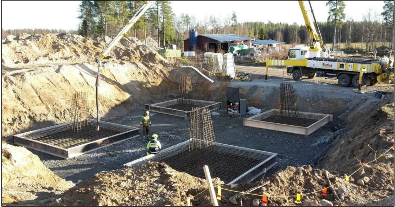
Kuva 3.5. Vapaasti seisovan pylvään perustuksen pohjatöitä.
