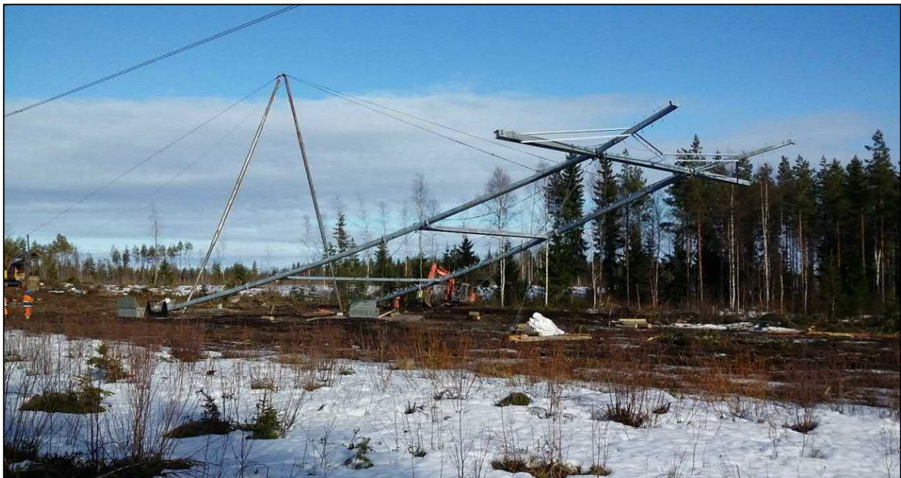
Kuva 3.6. Voimajohtopylvään pystytys.
