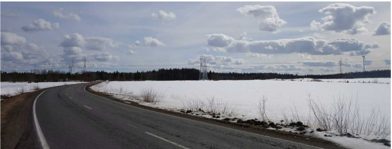
Kuva 8.3. Havainnekuva, läntinen reittivaihtoehto Tammelantieltä etelä-kaakkoon. Voimajohtoreitti sijoittuu nykyisen 2x110 kV voimajohtoreitin rinnalle, kuvasovitus Miikka Saranpää 2022.
