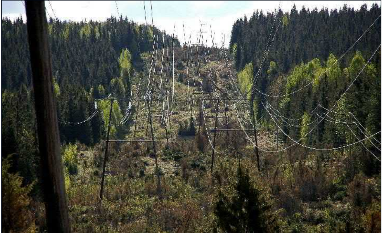
Kuva 3.7. Esimerkki valikoivasta raivauksesta.
