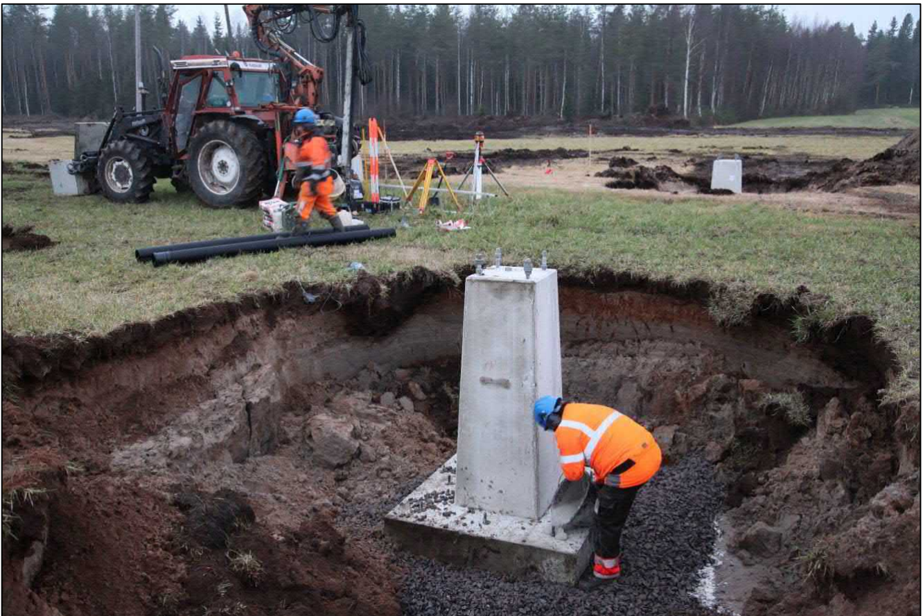
Kuva 3.4. Pylvään perustuselementin asentaminen.
