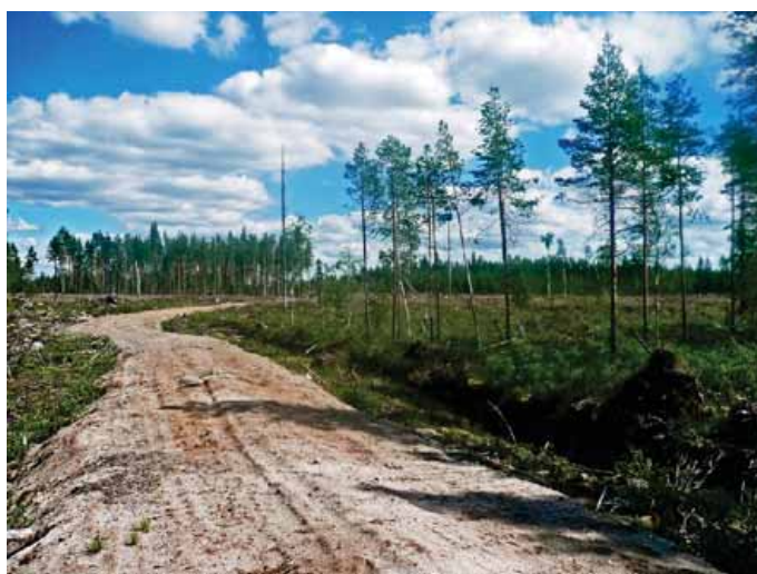
Kuva 15. Uusi metsätie Iso Kortenevan pohjoispuolella.
