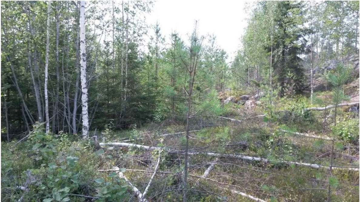
Kuva 9-4. Huoltotie voimalalle 9 kulkee kuivan kankaan taimikoilla Pihlajakallion läheisyydessä, muutoinkin pääsääntöisesti varputurvekankailla.
